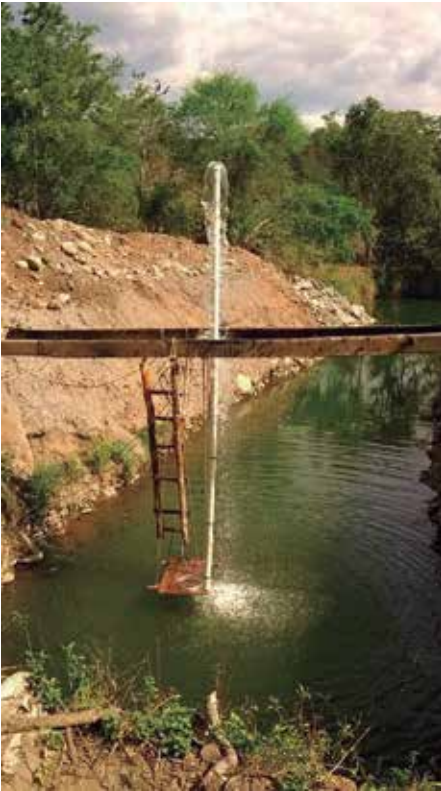
■ Llenado de un reservorio para riego que almacena el agua del río Guachicono, filtrada naturalmente por los suelos rocosos y profundos. El líquido, sin sedimentos, será impulsado 150 m arriba por pequeñas bombas de presión para abastecer los potreros de las lomas. Foto: Luis Fernando Castro.
